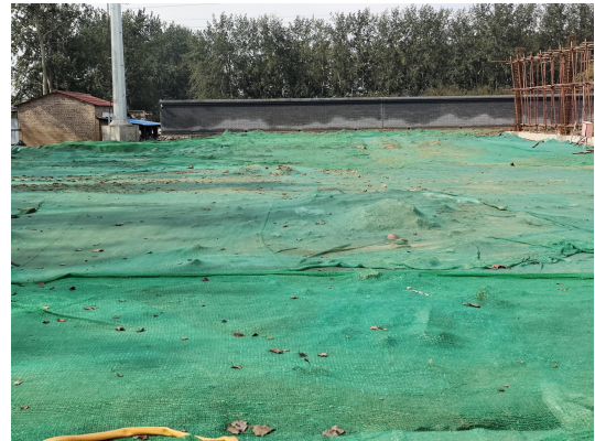
施工临时苫盖
