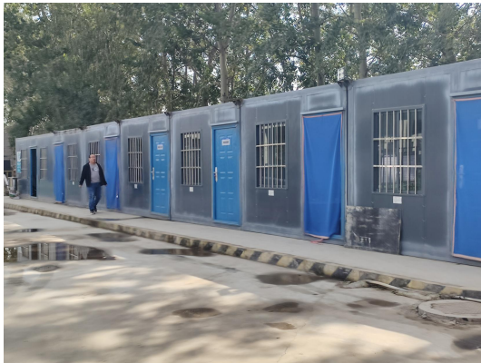
施工生活区及硬化
